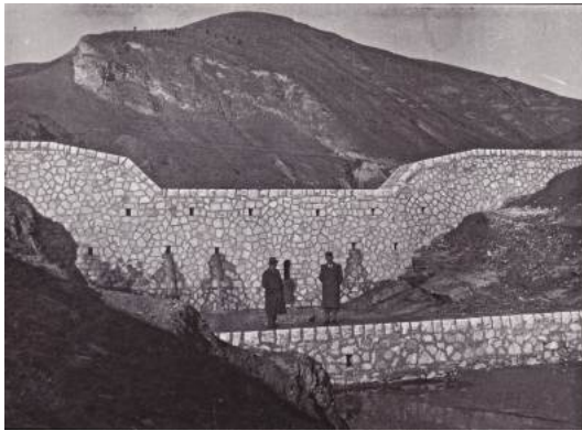
Φώτο 6: 1939, Φράγμα ανάσχεσης στον Κουραδιάρη (αρχείο Α. Καπετάνιος).
