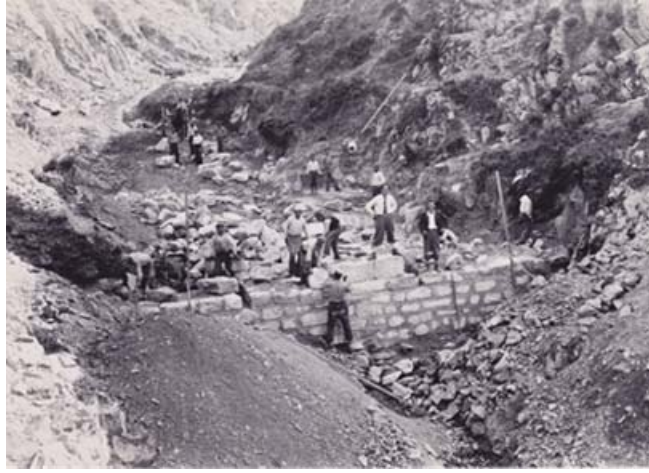
Φώτο 3: 1939, Κατασκευή φράγματος στην Τσαριτσάνη (αρχείο: Α. Καπετάνιος).
