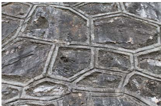
Φώτο 1 και Φώτο 2: Λεπτομέρειες ξηρολίθινου και λιθοδόμητου τοιχίου φράγματος ανάσχεσης (αρχείο : Β. Κατσάρας).
