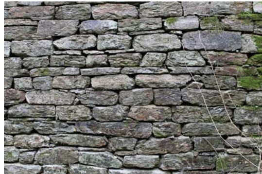
Φώτο 1 και Φώτο 2: Λεπτομέρειες ξηρολίθινου και λιθοδόμητου τοιχίου φράγματος ανάσχεσης (αρχείο : Β. Κατσάρας).
