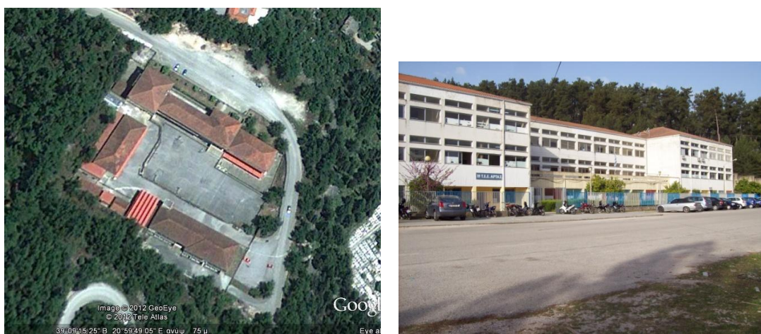
Σχήμα 1, 2: Άποψη του σχολείου μας από ψηλά και η κεντρική είσοδος
